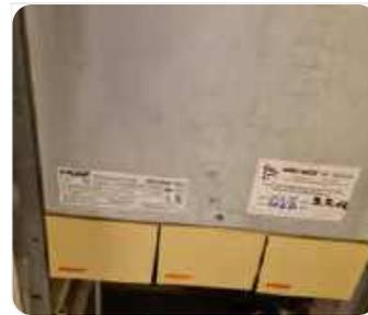
Die Warmwassererwärmung ist zur Zeit dezentral geregelt. Das bedeutet die einzelnen Boiler sind im Sonderrecht. Bei einem Heizungsersatz lohnt sich die Überlegung, ob man auf eine zentrale Warmwassererwärmung umsteigen möchte. Dies bedingt auch gewisse Anpassungen an den Sanitärleitungen. Kostenpunkt: Ca. CHF 7'000.- wobei ein Gesamtpaket in Betracht gezogen werden sollte.
