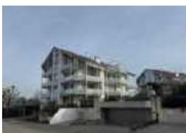
Es bestehen Wärmebrücken im Bereich der Fensteranschlüsse, Balkone, Gebäudesockel, Wandanschlüsse und Steildach.
