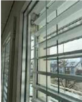
Türen und Fenster aus Erstellungsjahr (1991), 2-fach Wärmeschutzverglasung.
