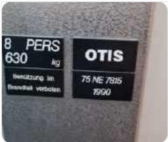
Die Aufzugsanlage ist aus dem Baujahr 1990. Somit bereits 35-jährig. Der Lift hat eine grundsätzliche Lebensdauer von 30 Jahren. Beim Lift ist darauf zu achten, dass der jährliche Service sorgfältig durchgeführt wird. Einen Ersatz/Sanierung in rund 5 Jahren wird empfohlen, damit das Ausfallrisiko minimiert wird. Kostenpunkt: Ca. CHF 125'000.-
