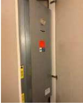
Die Warmwasseraufbereitung erfolgt derzeit dezentral über elektrische Warmwasserspeicher, die sich in den einzelnen Wohneinheiten befinden. Diese haben ihre Nutzungsdauer erreicht und sollten ersetzt oder durch eine zentrale Lösung abgelöst werden.
